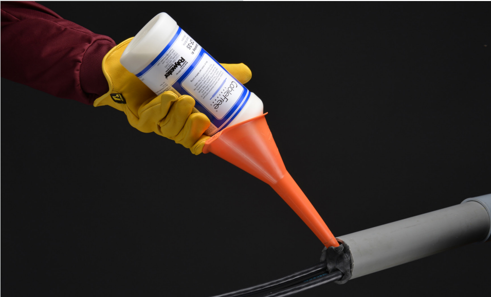
Pouring CableFree Loosener into the conduit
