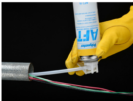
Steel conduit installation
